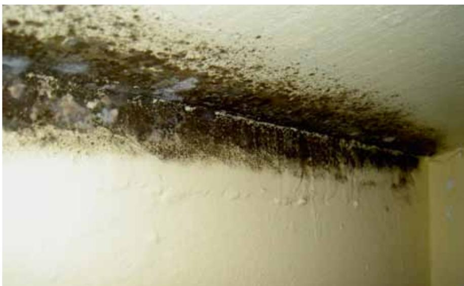
Verschimmelte Heizkörpernische. Neue Fenster, bauliche Probleme und eine vom Heimwerker installierte Innendämmung erzeugten eine massive Taupunktunterschreitung im Winter.
